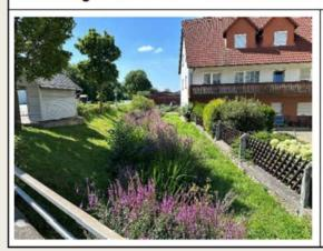
In diesem innerörtlichen Abschnitt ist der Palmbach sehr stark bewachsen, wodurch Abflussquerschnitt verloren geht. Durch die unterschiedlichen Böschungshöhen tritt das Wasser auf Seite der Siedlungsfläche aus dem Gewässer aus, weshalb gerade in diesem Abschnitt ein freier Abflussquerschnitt zur Minimierung des Überflutungsrisikos empfehlenswert ist.
